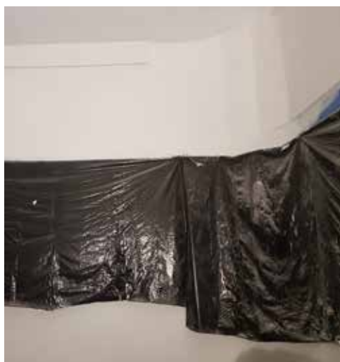
Figs. 178 e 179. Reforma do forro e aplicação de massa acrílica branca para nova pintura mural nas paredes e teto, 24 de abril de 2019.
