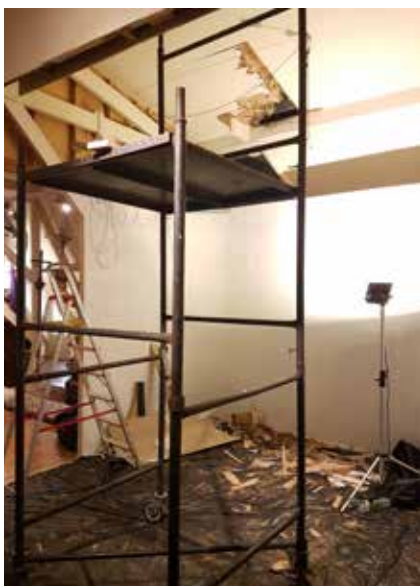
Figs. 175 e 176. Remoção do antigo forro e instalação de novas vedações, abril de 2019.
