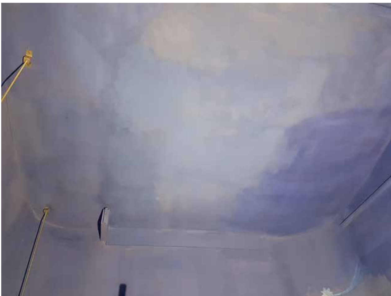
Fig. 184. Teresa Vidigal. Aplicação de pigmentos (base de fundo) para a pintura do teto (céu), 9 de maio de 2019.
