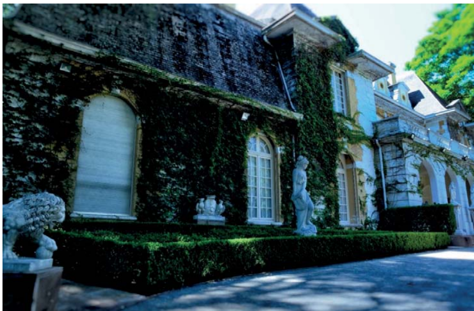
Fig. 3 – Fachada principal do Palacete CIJY. Foto: Imagem cedida pela CIJY.
